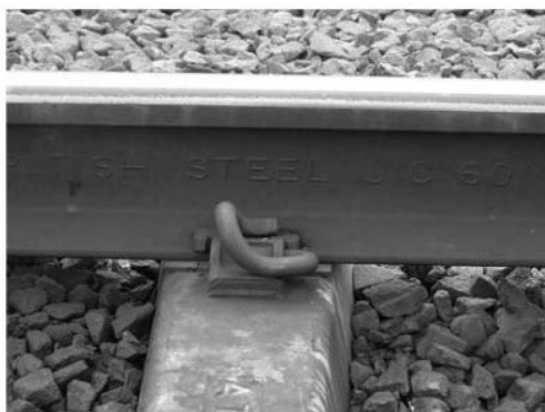
14 pav. Pandrol e-clip tipo sąvarža
